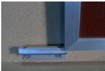
Wandmontage (mit Winkel und Einlaufschuh)
